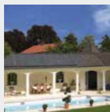
Indach (im Dach integrierte) Großflächenkollektoren
